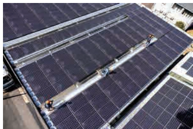
▲太陽光発電 設置の様子
